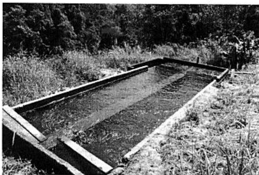
Foto 01 – Captação Alto Rio Claro (Fonte: SABESP)
