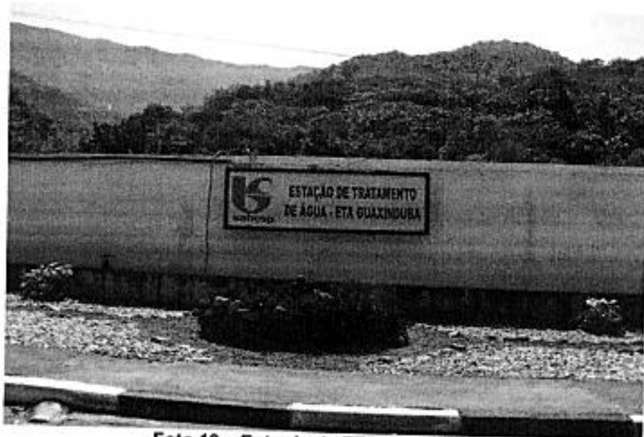
Foto 10 – Entrada da ETA Guaxinduba
