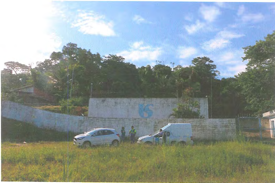
Foto 21: Sistema Guaxinduba – Reservatório Benfica, capacidade 1.750m 3 .
