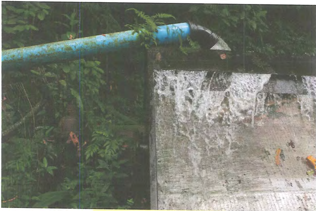
Foto 29: Sistema Tabatinga – Captação Rio Mococa – Peneira Estática.
