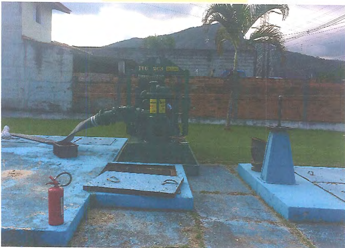
Foto 52: Sistema Esgotamento Sanitário (SES) Indaiá – Estação Elevatória de Esgotos (EEE) Final Tinga-Poiães.
