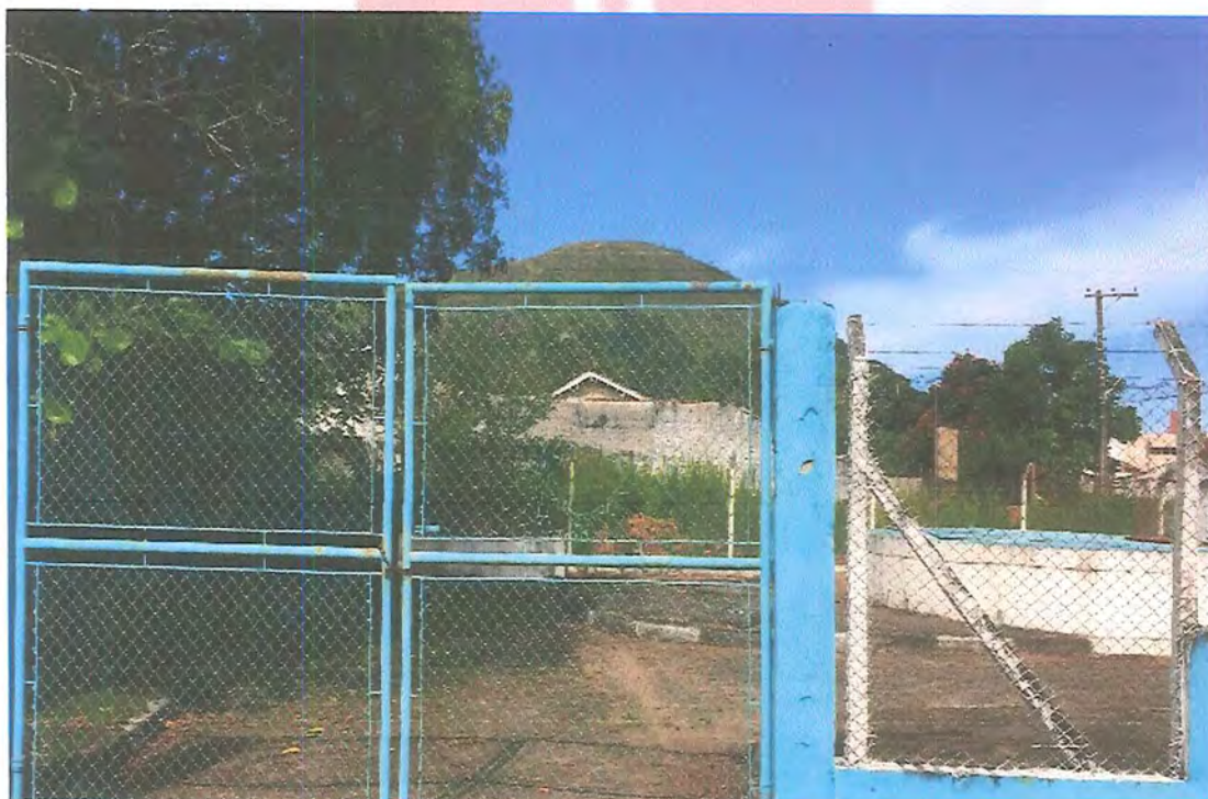
Foto 56: Sistema Esgotamento Sanitário (SES) Martin de Sá – Estação Elevatória de Esgotos (EEE) Final Brejaúva.
