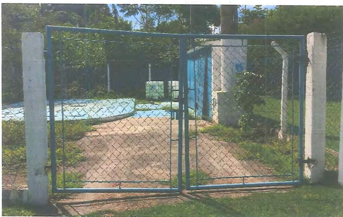
Foto 59: Sistema Esgotamento Sanitário (SES) Massaguaçu – Estação Elevatória de Esgotos (EEE) Final Massaguaçu.
