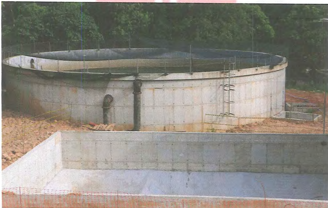
Foto 20: Sistema Guaxinduba – Reservatório Guaxinduba, capacidade 2.000m 3 .
