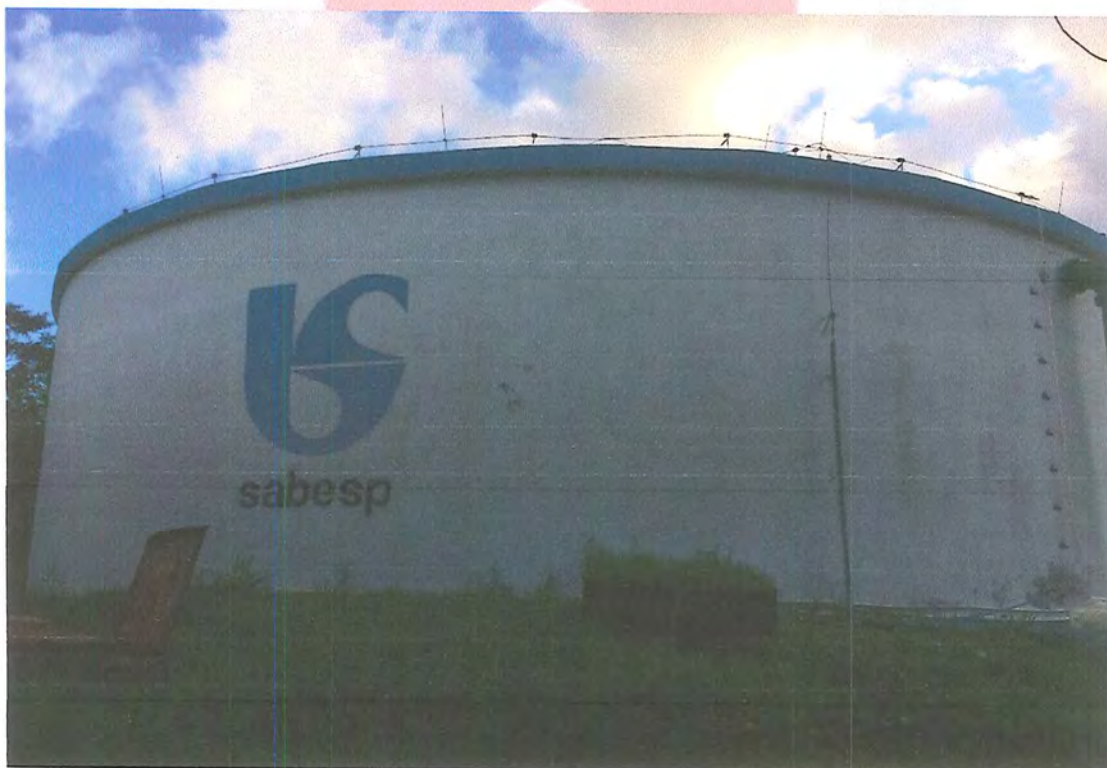
Foto 26: Sistema Massaguaçu – Reservatório Massaguaçu, capacidade 1.500m 3 .
