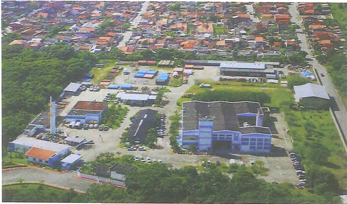
Foto 5: Sistema Porto Novo – Vista Aérea da ETA Porto Novo – Fonte: SABESP.
